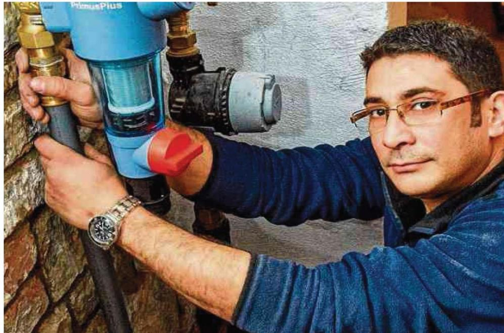
Mohamad Kanoun beim Einsetzen eines Verbindungsstückes zu einem Filter an einer Wasserleitung. FOTO: ENGELBERT PULICHER
